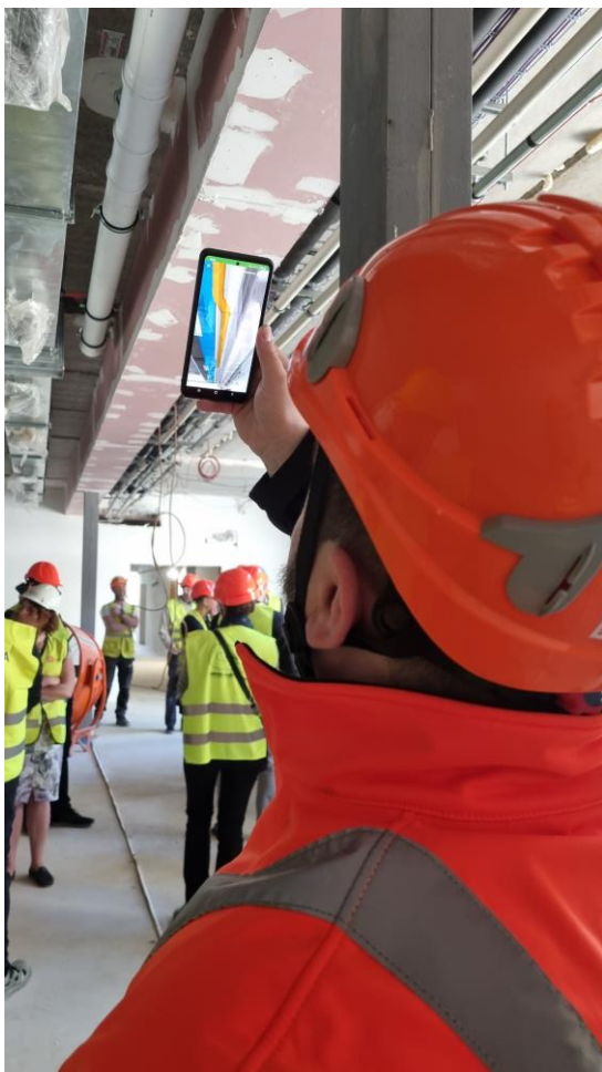
Použití rozšířené reality v praxi – kontrola průběhu potrubí ze strany managera BIM pana Čermáka
